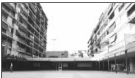
Rehabilitació dels interiors del barri del Canal
