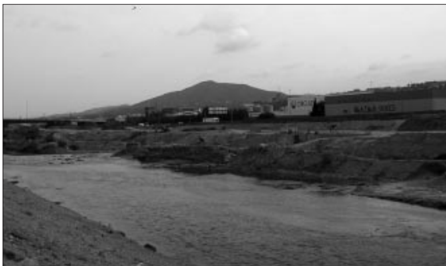
Obres al riu Llobregat a l'alçada de Molins de Rei
